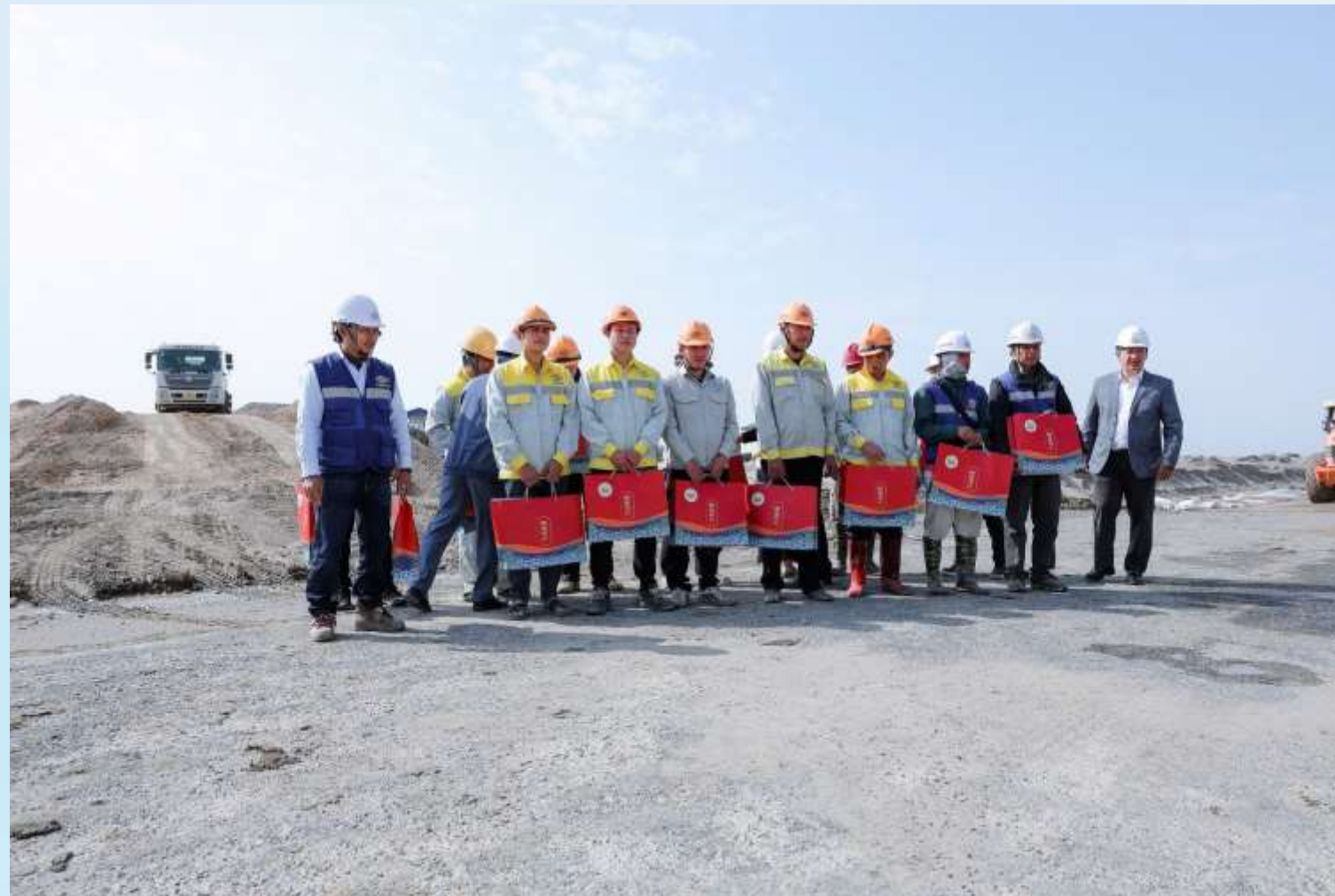
Công ty tổ chức trao quà tết cho các công nhân trực tiếp làm việc tại dự án Bình Giang
